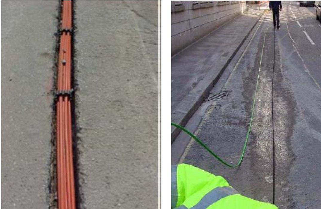
Obr. 17 Montáž optických káblov do plytkých úzkych drážok. [Zdroj: EMTELLE.]
